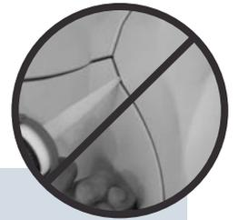
**Ne pas coller ni enduire au niveau des joints.**
